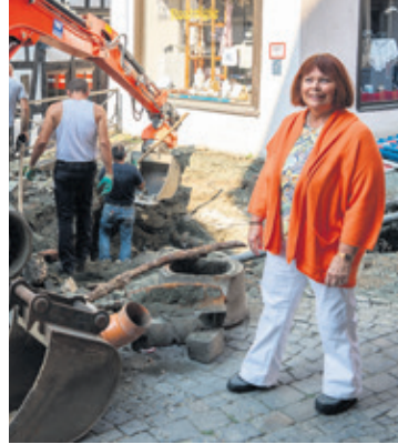
Bärbel Keiner bei den Bauarbeiten der neuen Pflasterung in der Altstadt, die ein barrierefreies Bewegen erleichtert
