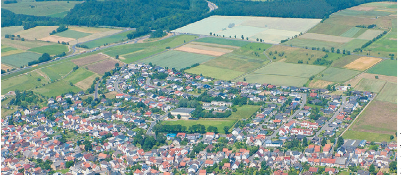
Das helle Feld am oberen Bildrand wird der erste Bauabschnitt des Gewerbegebietes Münchholzhausen-Nord I, begrenzt links von der Autobahn, oben bis an den Wald, rechts bis an den Dorlarer Weg und unten bis an die Landesstraße
