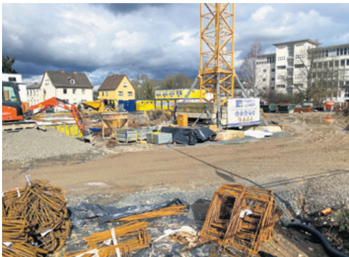
Der Neubau der Feuerwache I hat begonnen
