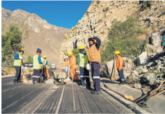
Straßenbauarbeiten in Peru
